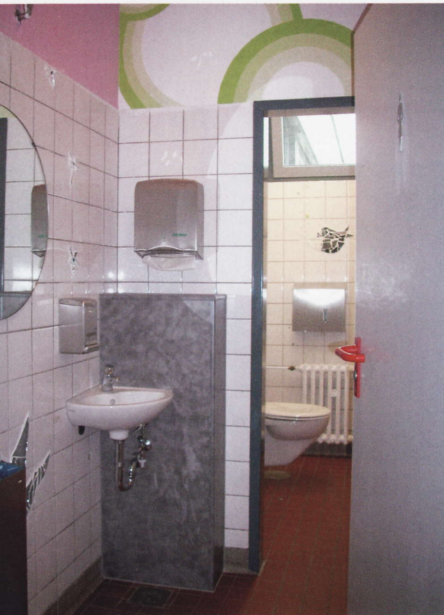
Das im Eckbereich montierte Waschbecken verhindert den Kontakt des Rückens mit der aufschlagenden Tür beim Händewaschen. Frische und freundliche Farben und Formen lassen keine bedrückende Atmosphäre aufkommen.
